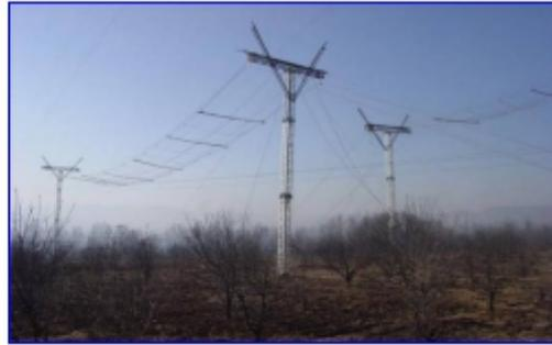
图9.2.3-15 铝合金跨越架尼龙网封顶跨越现场图
