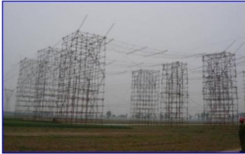
图9.2.3-14 钢管跨越架尼龙网封顶跨越现场图
