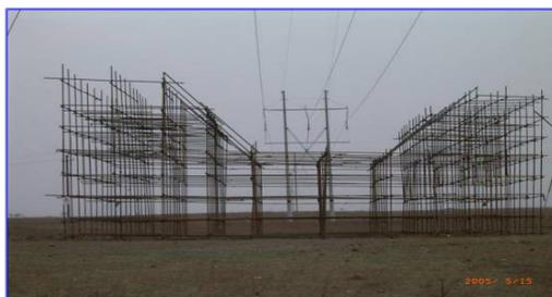
图9.2.3-12 钢管跨越架施工现场图
